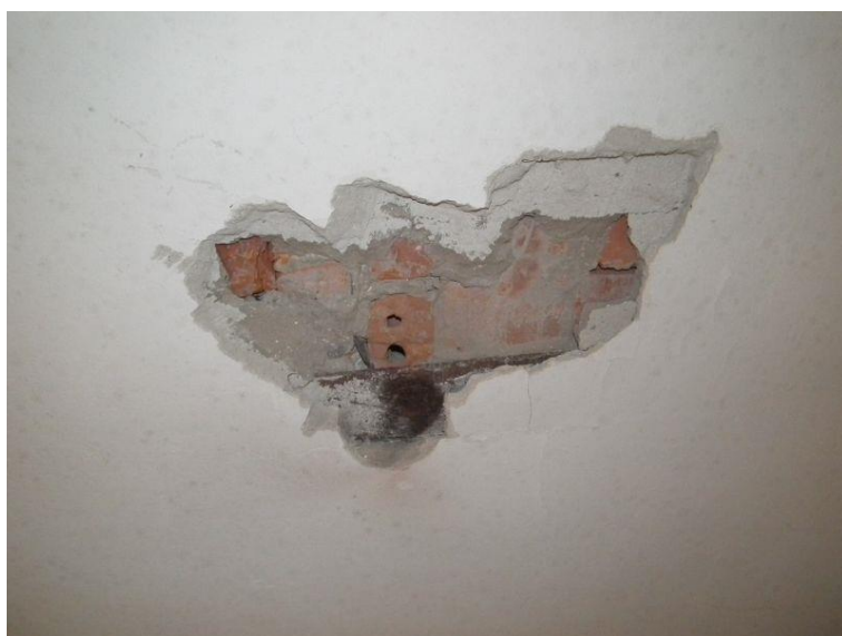
Fot. 8. Odkrywanie belki i cegieł stropu na I piętrze.
