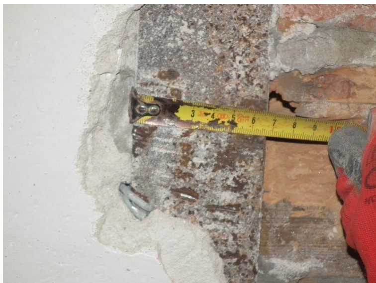
Fot. 7. Odkrywanie belki i cegieł stropu na parterze.
