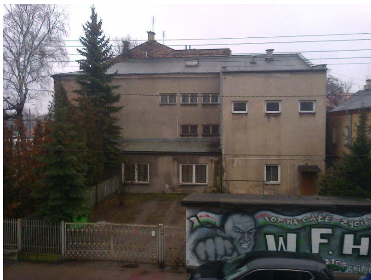
Fot. 1. Widok ogólny budynku
