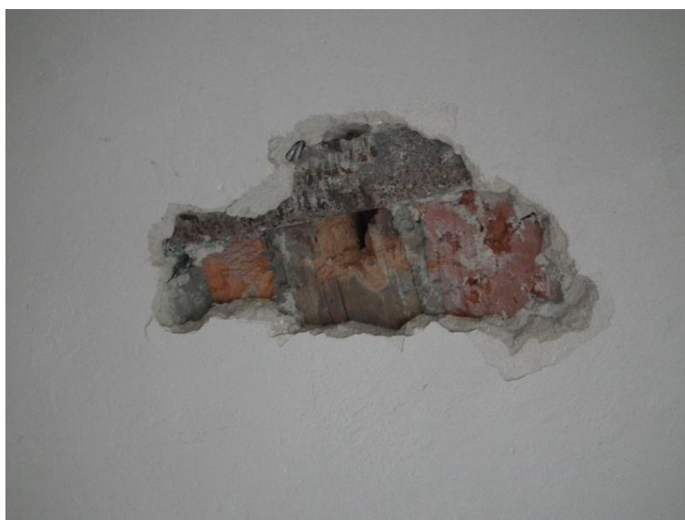
Fot. 6. Odkrywka belki i cegieł stropu na parterze.
